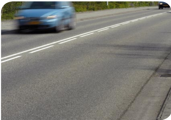
Dubbele asstreep, waarvan één onderbroken is: inhalen mag vanaf deze kant, niet vanaf de andere kant.
